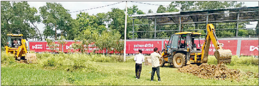
यमुनानगर। गांव शाहपुर में अनाधिकृत कॉलोनी में अवैध निर्माण तोड़ती जेसीबी मशीन।
